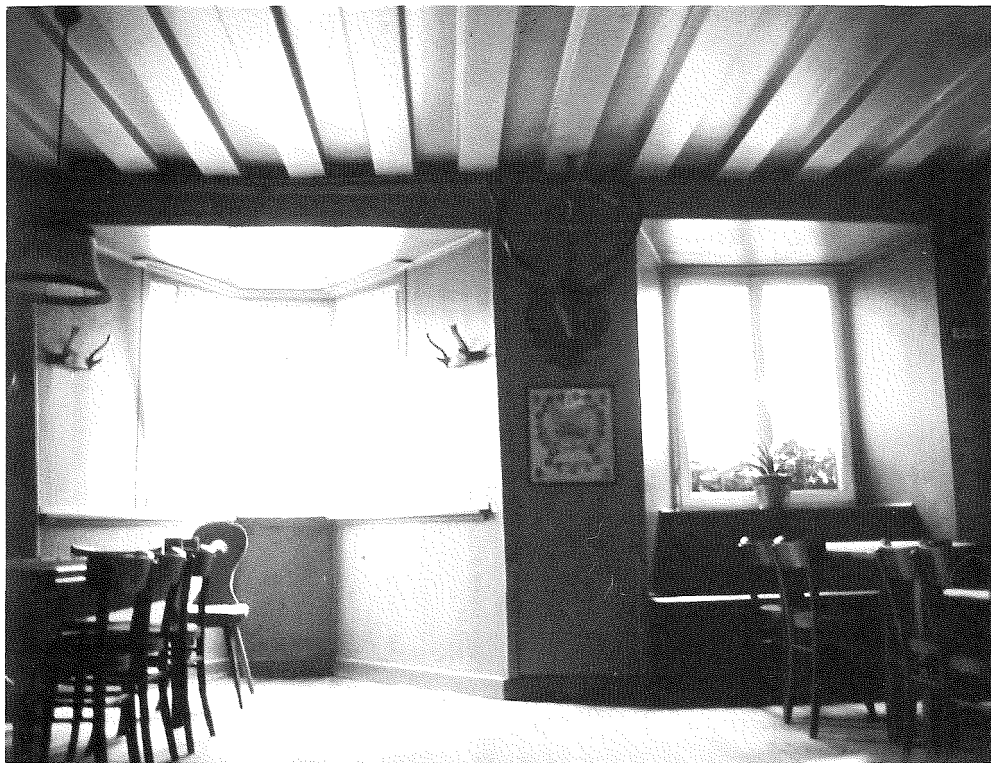
Abb. 12: Die Gaststube im ersten Stockwerk vor der Sanierung 1994/95
